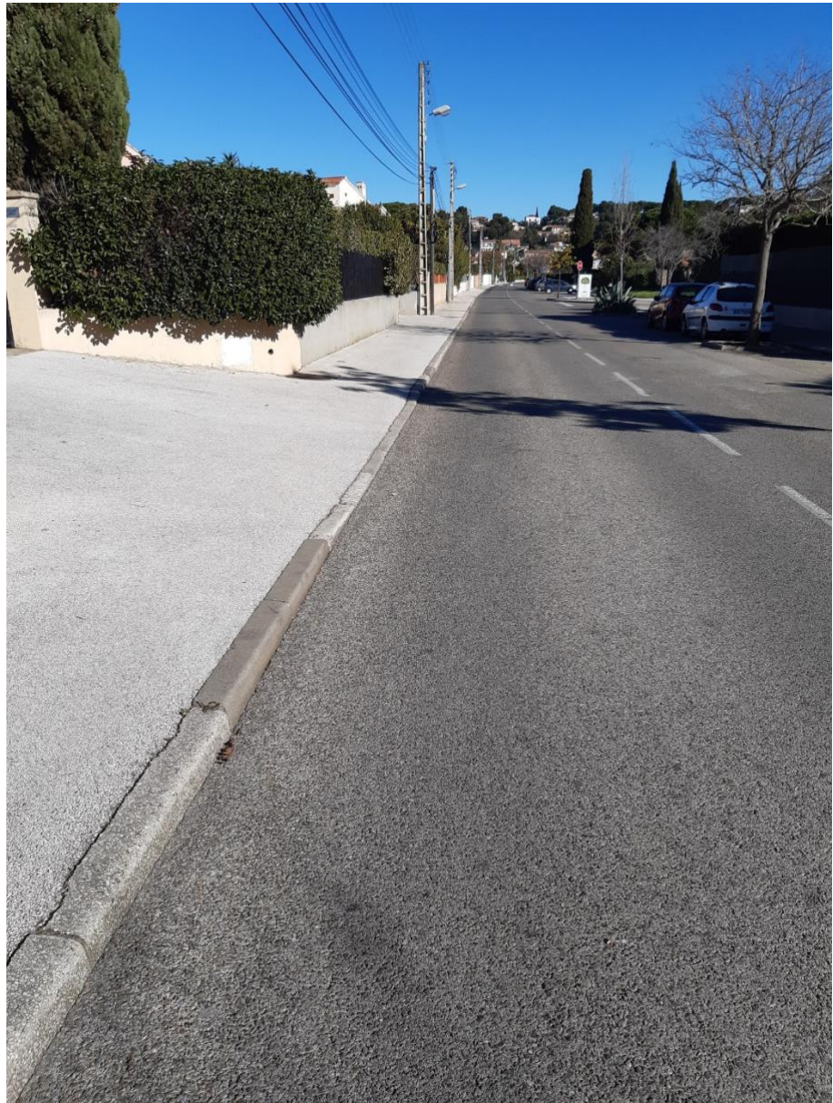
Dos d'âne et protection passage par barrières
